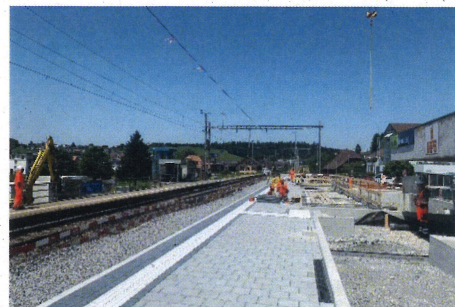
Neues Perron 1 mit Versteinerung
