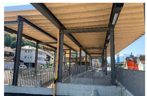
Neuer Zugang zu Personenunterführung mit Perrondach (Ostseite)
