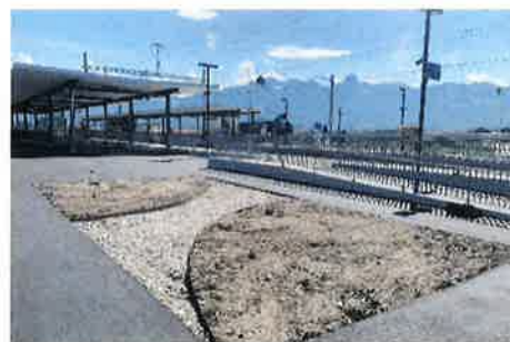
Begrünung der Bahnhofanlage in Arbeit
