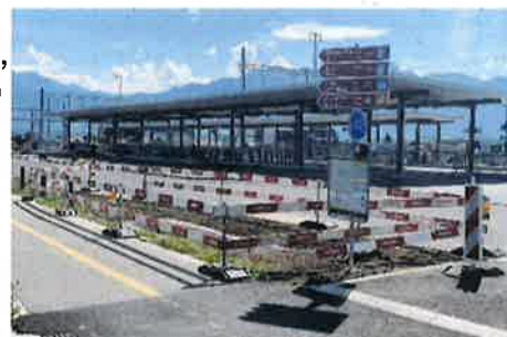
Umgebungsarbeiten auf der Ostseite
